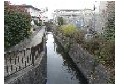
新八田橋上流部
