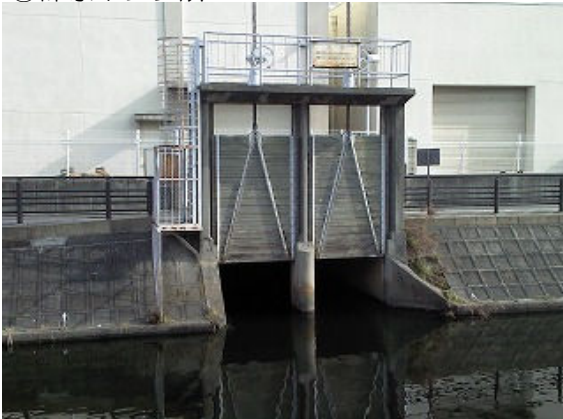
③篠原ポンプ所
