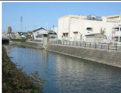
図 10-1. 篠原ポンプ所周辺
