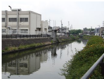
中流域(篠原ポンプ所周辺):繁殖ポイント
