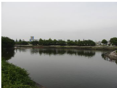
フェニックスブリッジから上流を見る
