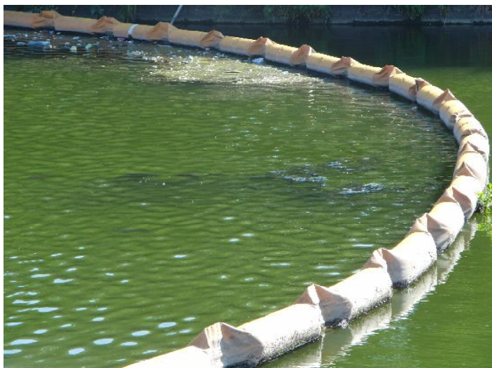
ゴミの流出防止用のフェンス
