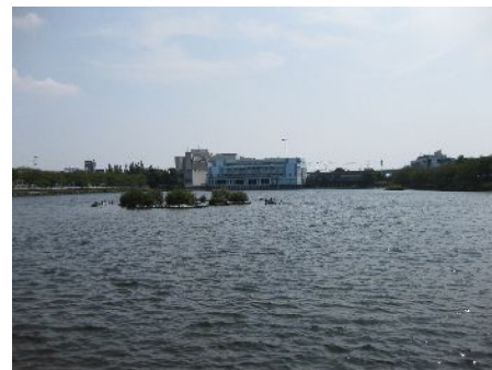
荒子川ポンプ所(海との境界)
