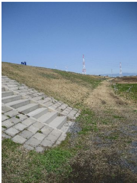
つくしの採取地である木曽川堤防 (愛知県愛西市福原新田付近)
